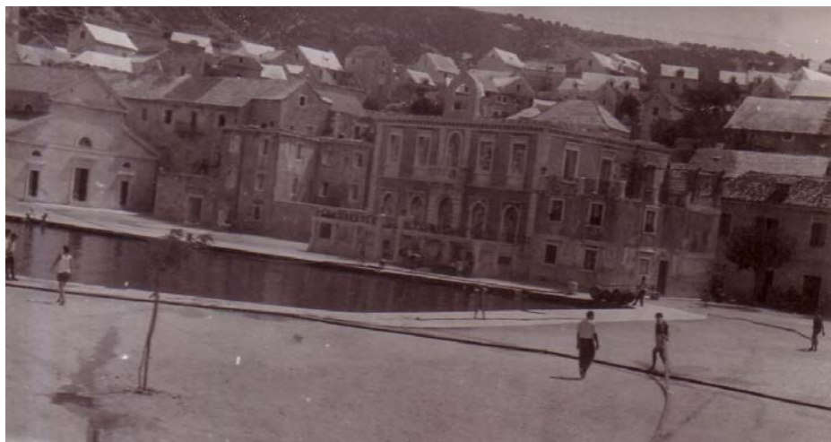
Fotografija 8: Spaljena kuća Moro u Portu, u prvom planu
