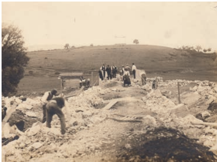
Sl. 9. Gradnja prilazne ceste i mosta podno Paračeve glavice, 1929. (Arhiv Marina Marasovića, inv. br. AFMM-10.4)
